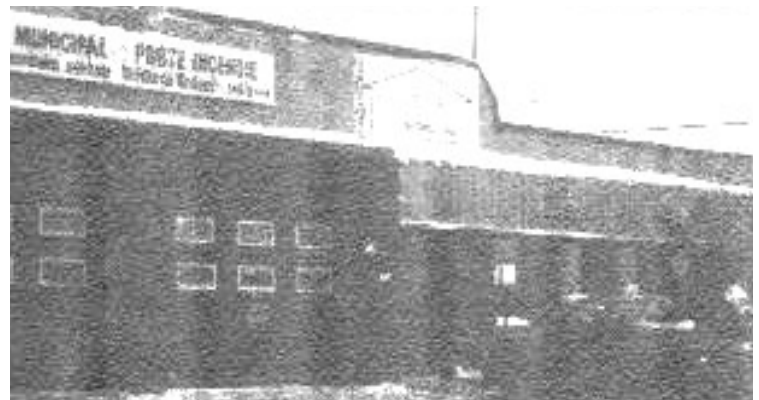
1972 CASERNE DES POMPIERS
